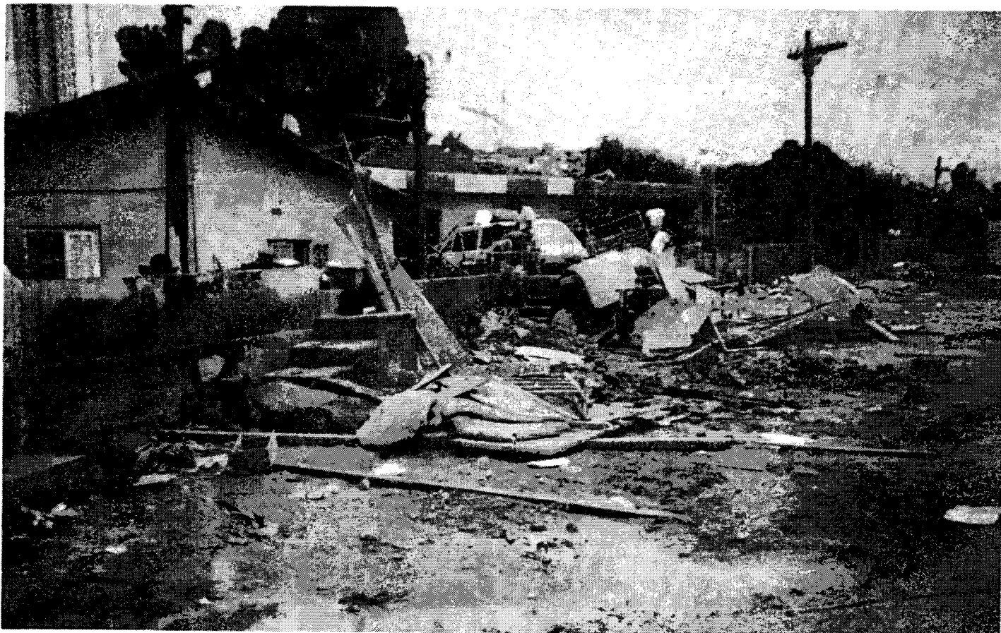
Consequências do transbordamento do Córrego Gamelinha, pouco antes de sua embocadura no rio Aricanduva, 12/02/83.
