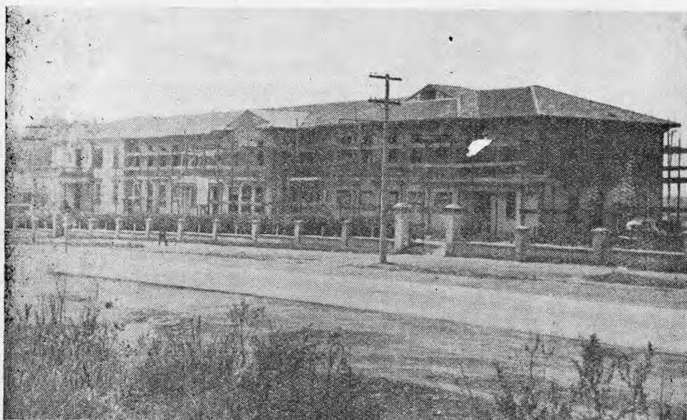
PAVILHÃO PARA A ENFERMARIA DE PARTURIENTES (Em fase de conclusão)
