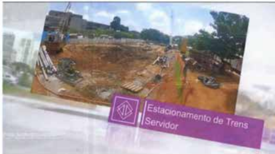
Imagem 15: Linha 5 Lilás do metrô – Estacionamento de Trens Servidor. Fonte:site do Metrô
