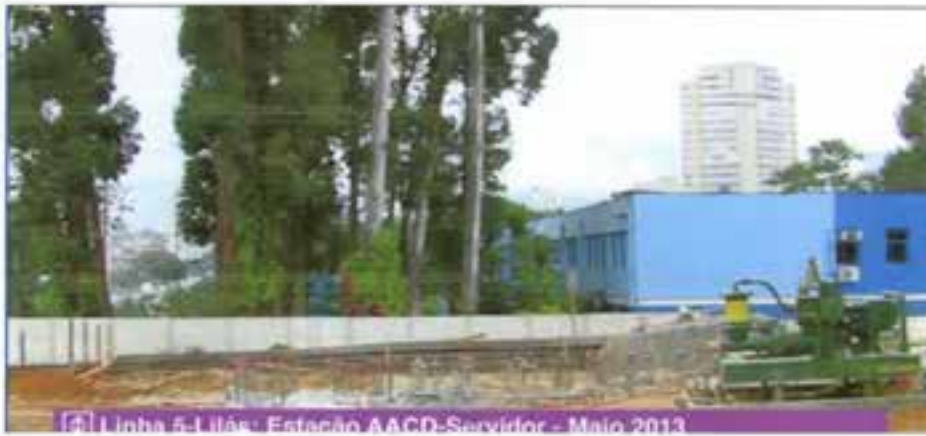
Imagem 14: Linha 5 Lilás do metrô – Estação AACD – canteiro de obras. Fonte:site do Metrô
