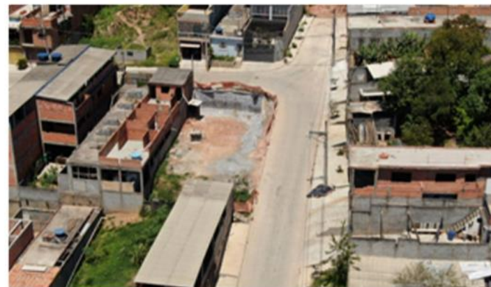
Obras de contenção geotécnica - Rua Projetada 1
