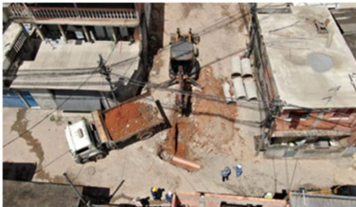
Vista superior da Travessa Carvalheiras, mostrando a execução dos serviços de implantação das redes de esgotamento sanitário e de drenagem pluvial.
