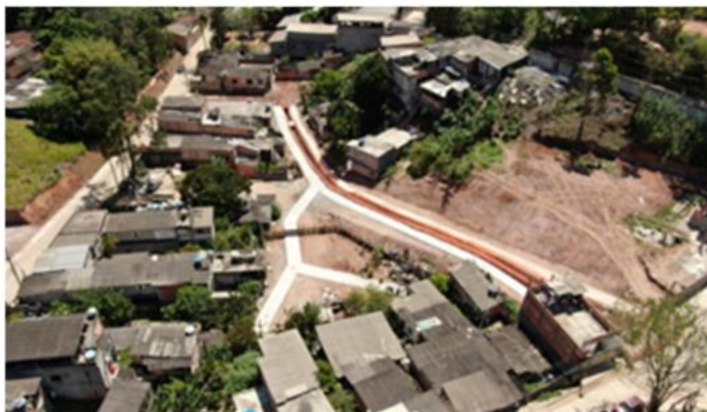
Execução de canalização do córrego em aduela em "U".
