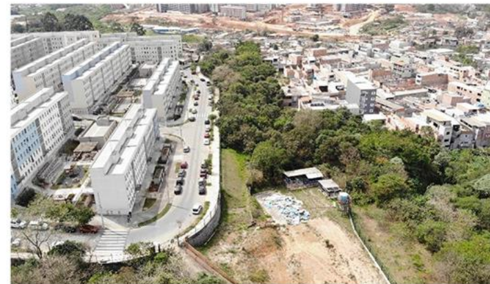
Edificações e áreas verde em manutenção
