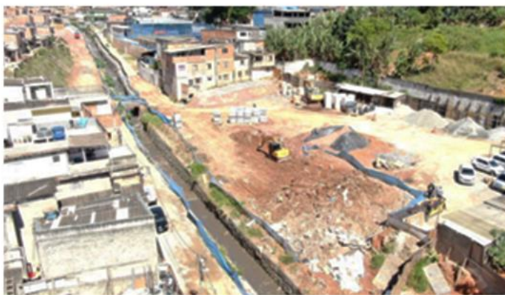
Vista do trecho das obras incluindo a canalização do córrego, depósito de materiais, canteiro principal.
