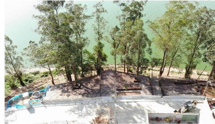
Execução dos decks - Mirante
