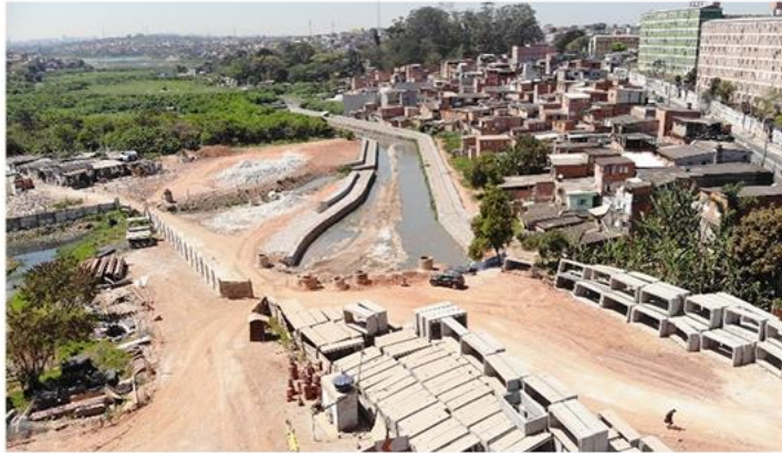
Canalização de córrego
