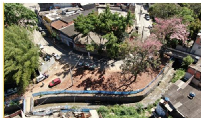
Travessia provisória na parte inferior esquerda da foto, extensão da canalização do córrego em gabão.
