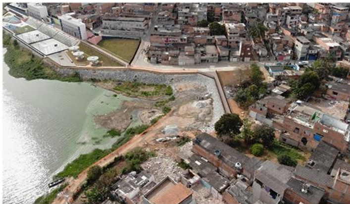
Etapa 3 - Frente 2 - Urbanização e edificações
