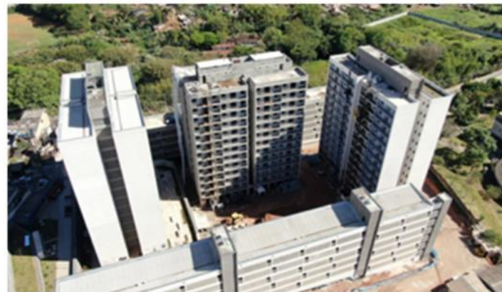
Vista geral das obras dos edifícios Tipo 1, 2, 3ª, 3B e 3C.
