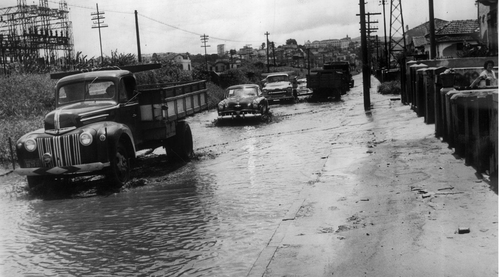
Carros atravessam alagamento na avenida Cruzeiro do Sul, em São Paulo, após chuva. São Paulo, SP, 29.10.1957. Foto: Folhapress.
