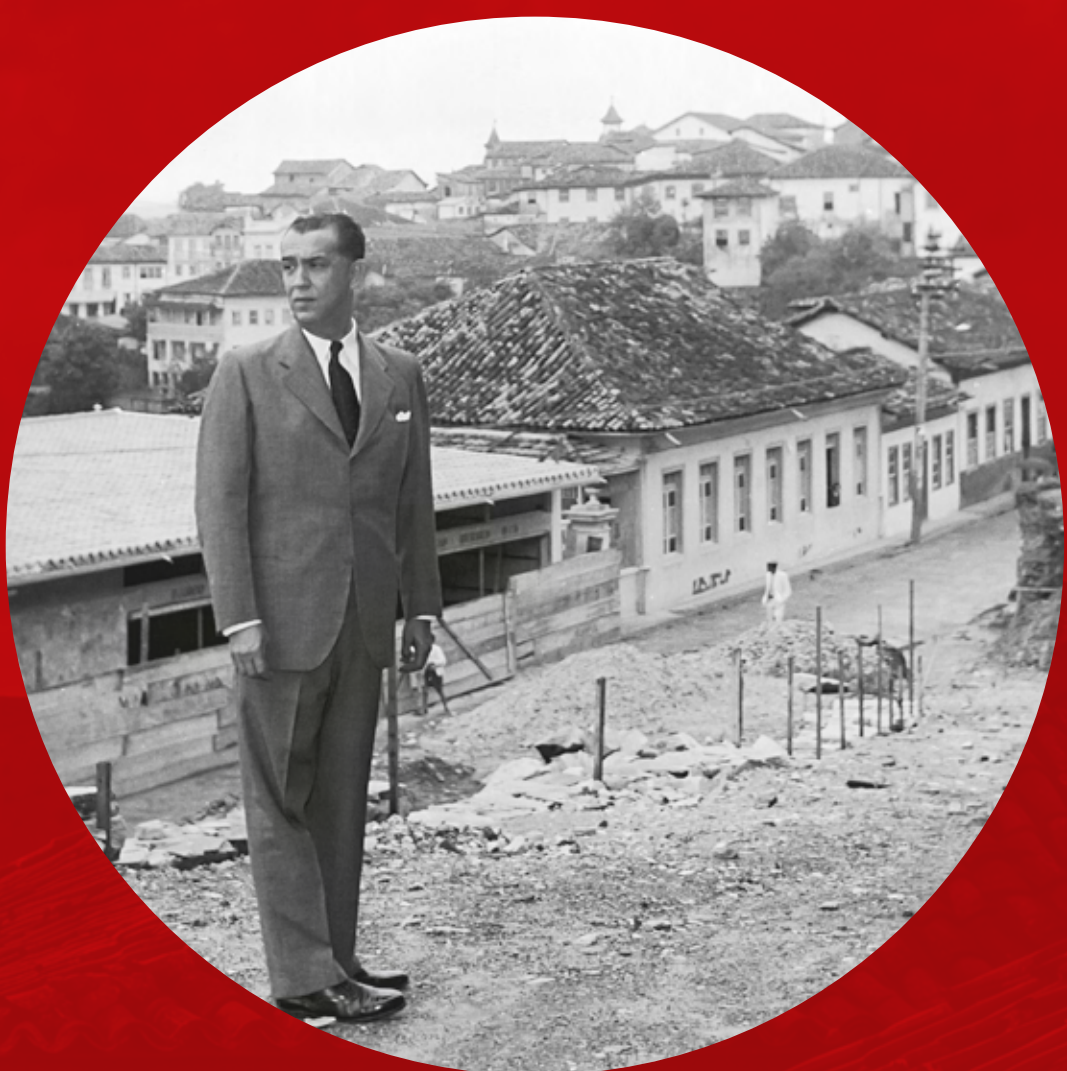
Diante de obras em Diamantina. (1951) Acervo Casa de Juscelino Kubitschek
