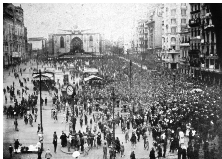
REVERÊNCIA • Missa na Catedral da Sé (em construção) pela chegada do Jahú, em agosto de 1927. No alto da igreja foi colocada uma réplica do hidroavião
